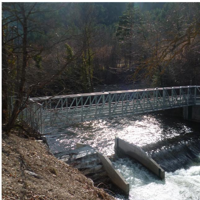
Le seuil d'Axat est situé sur la rivière Aude, environ 200 mètres en aval de la centrale de Saint Georges. Il permet la mesure limnimétrique pour le contrôle des débits de lâcher EDF en amont.
