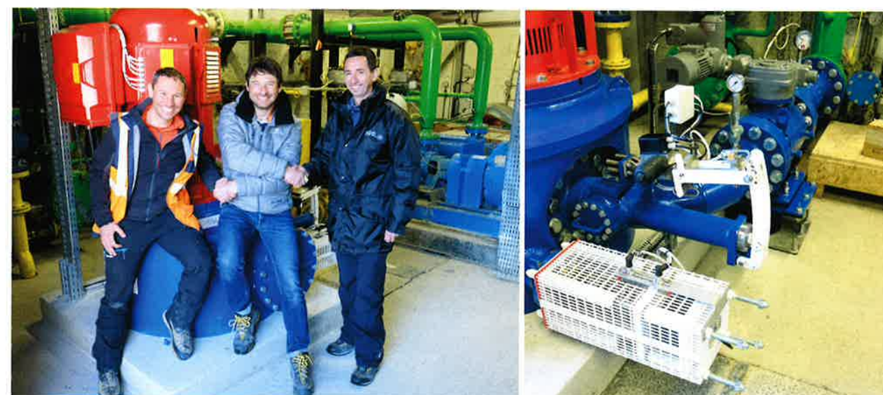
▲ La place disponible à côté des 2 pompes de l'usine de Chantemerle était trop restreinte pour implanter une turbine à 1 000 tr/min. D'où le choix d'une machine à 1 500 tr/min, un tiers plus petite.
