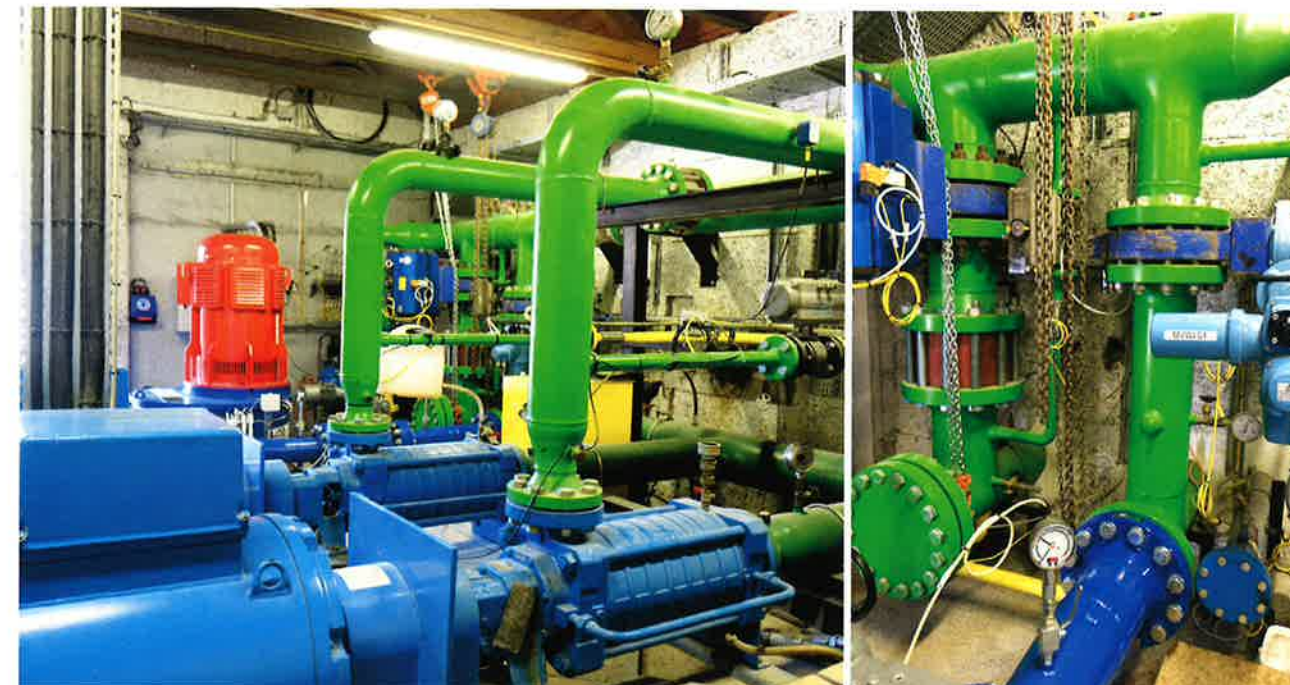
▲ La place disponible à côté des 2 pompes de l'usine de Chantemerle était trop restreinte pour implanter une turbine à 1 000 tr/min. D'où le choix d'une machine à 1 500 tr/min, un tiers plus petite.
